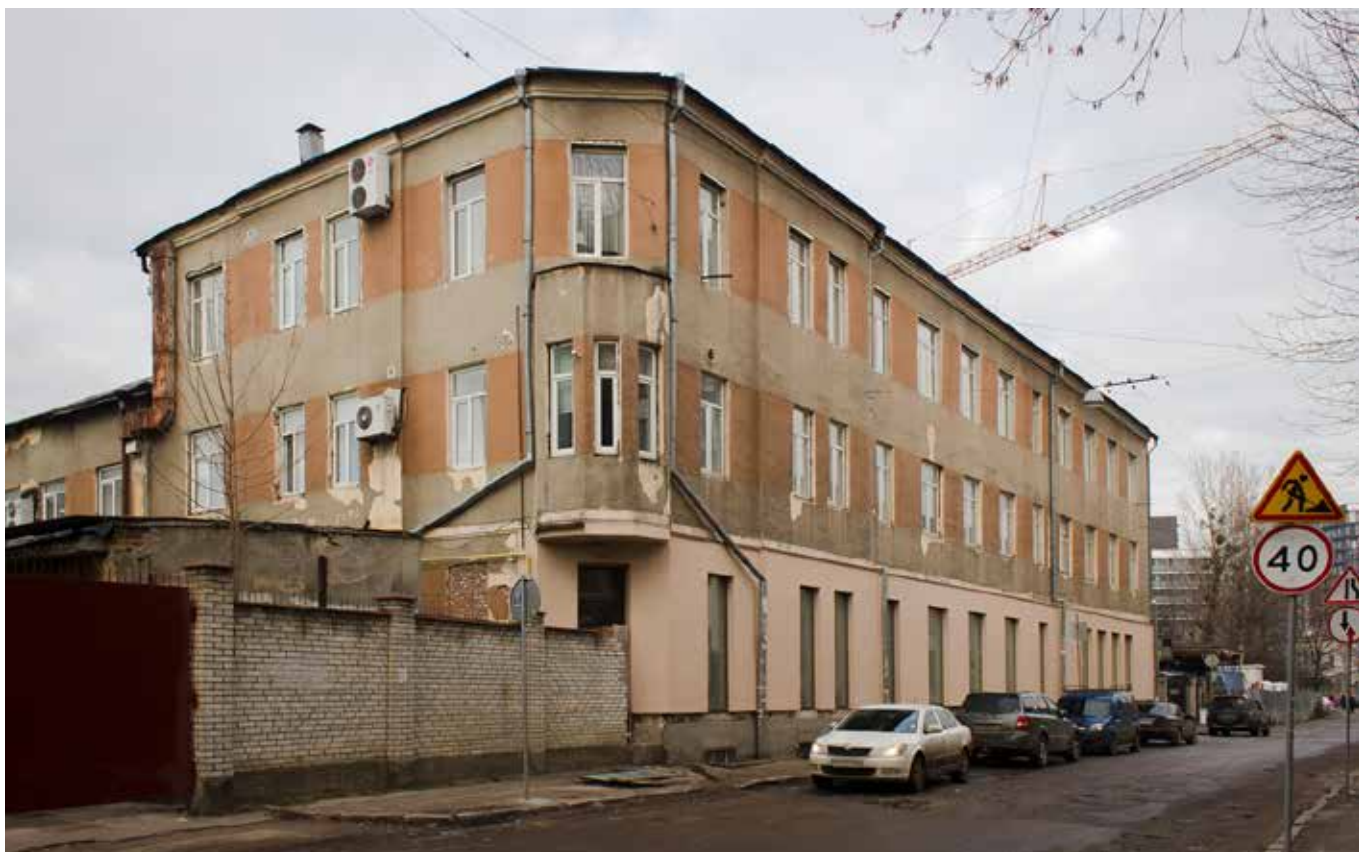
Будинок при вул. Германа, 15 (сучасна Лемківська), у якому був розташований осередок Єврейської служби порядку, 2018 р. Автор: Ольга Заречнюк. Джерело: Інтерактивний Львів, Центр міської історії
