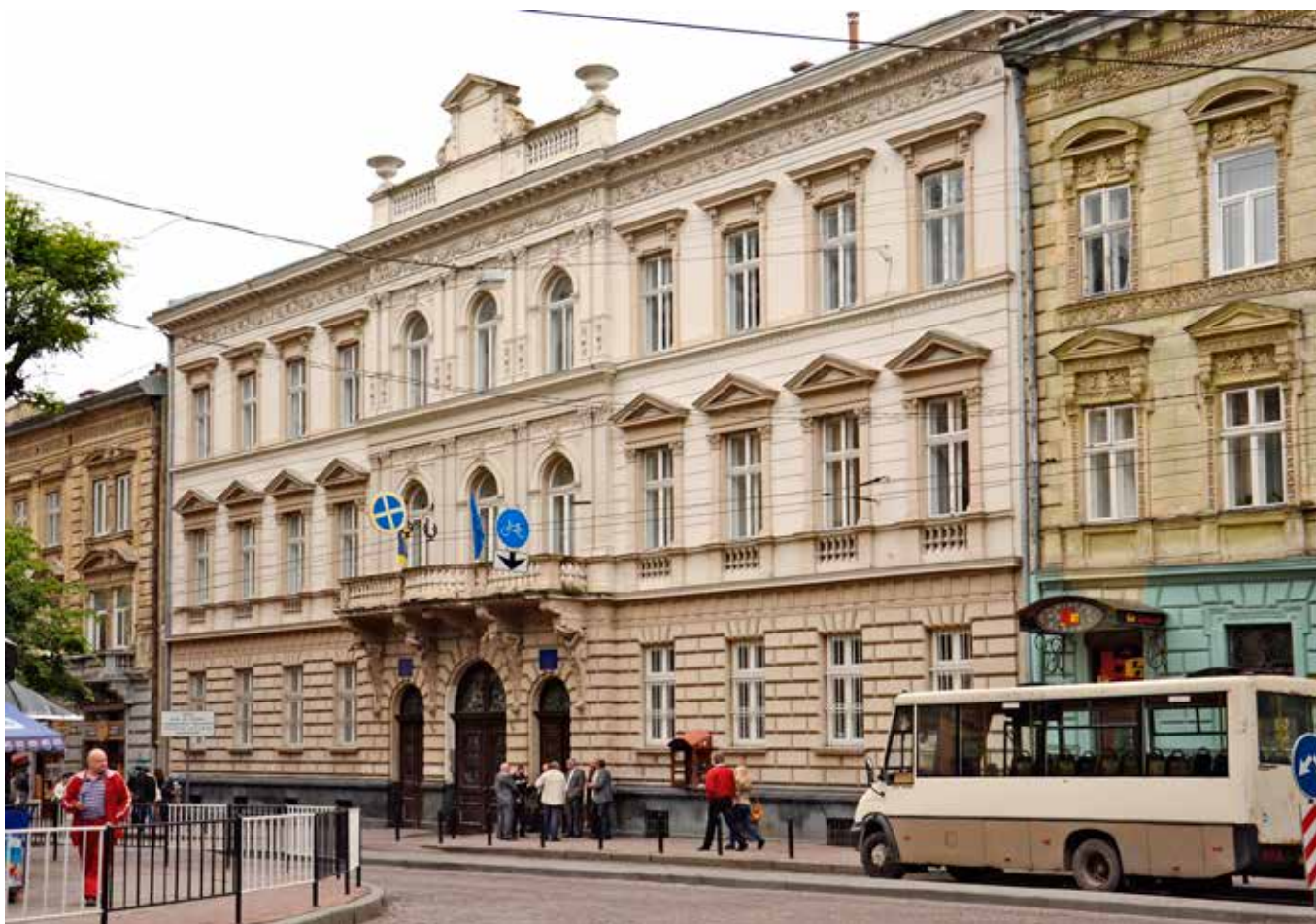
Будинок на вул. Січових Стрільців, 19, 2015 р. Автор: Мирослава Шлапак. Джерело: Інтерактивний Львів, Центр міської історії
